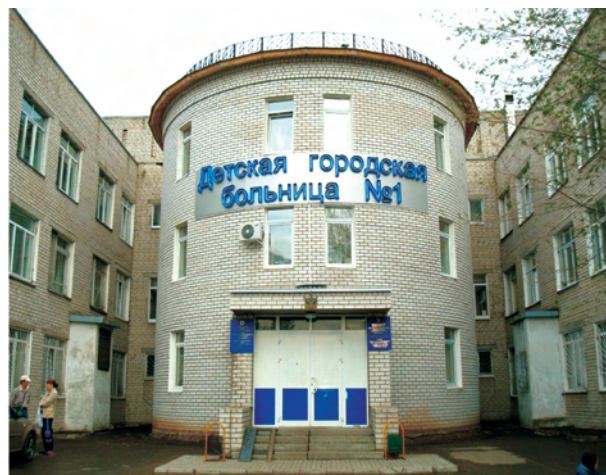
Входная группа после реконструкции, 2002 г
